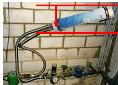
Montaje instalado en forma inclinada, pero la conexión siempre hacia abajo
